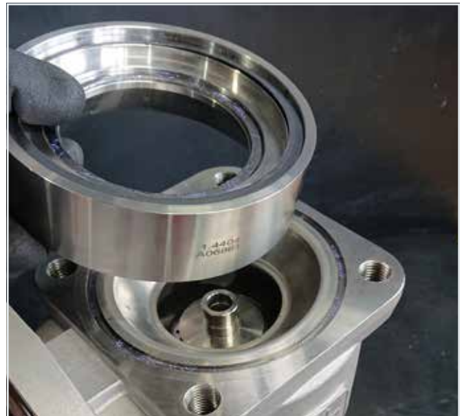
7.10 Balgenschutz und Anschweißplatte auf Gehäuse setzen.
