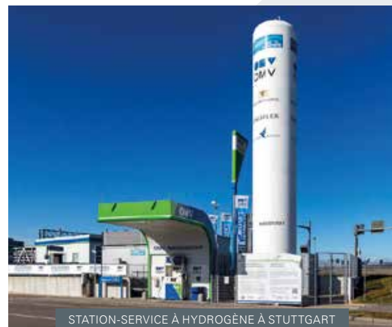
STATION-SERVICE À HYDROGÈNE À STUTTART
